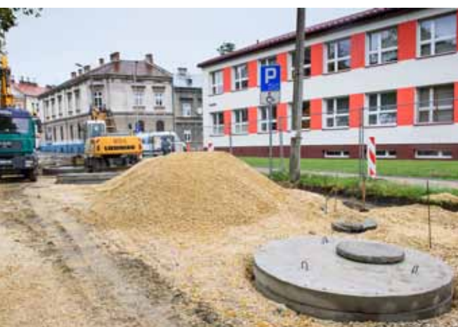
Ulica Bandrowskiego w trakcie modernizacji.
